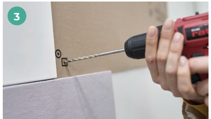
3 Marcaje / perforación Marking / perforation Markierung / bohrung Marquage / perforation
