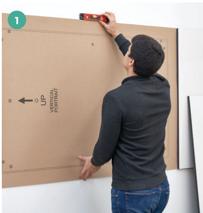
Presentación y nivelación · Appearance and levelling · Präsentation und nivellierung · Présentation et mise à niveau
